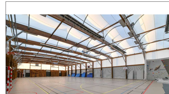
Gymnase de Annonay OLIVIER BONZON Architecte
