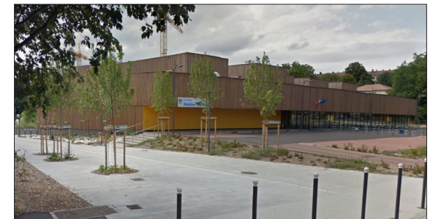
Gymnase P. Chevallier à Rillieux-la-Pape TECTONIQUES Architectes
