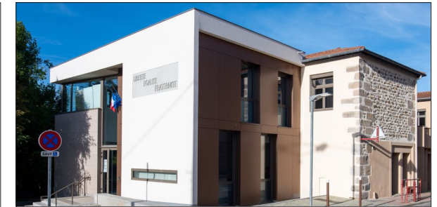
Restructuration de la mairie de Sorbiers JAMBRESIC architecte
