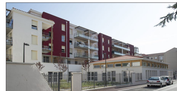
30 logements à St Chamond XXL Architecture
