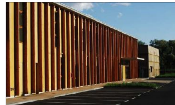
Centre Technique Municipal de Crolles BRENAS, DOUCERAIN Architectes
