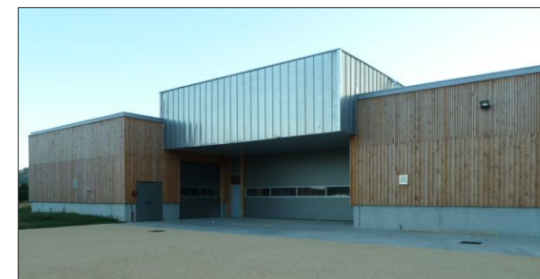
Centre Technique Municipal de Coublevie BRENAS, DOUCERAIN Architectes
