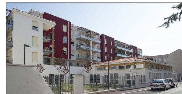
30 logements à St Chamond XXL Architecture
