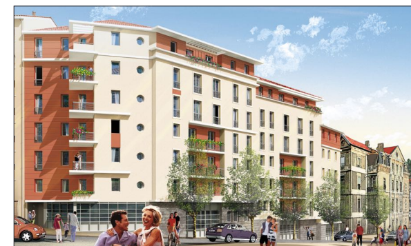
50 logements à St Chamond BERAUD Architecture Ingénierie
