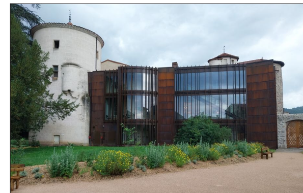
Château de Aurec-sur-Loire CROISEE D'ARCHI
