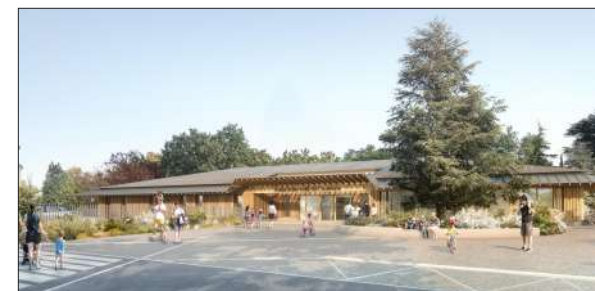
Ecole maternelle à Coublevie GALLET Architectes
