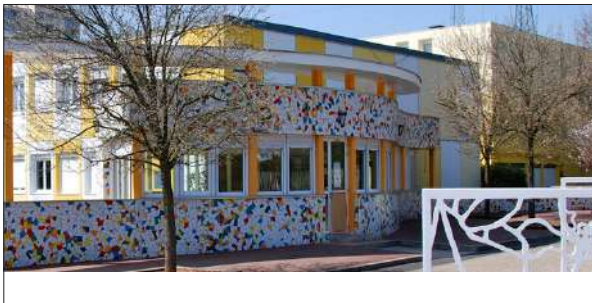
Collège Le puits de la Loire à St-Etienne BRUHAT & BOUVHAUDY Architectes
