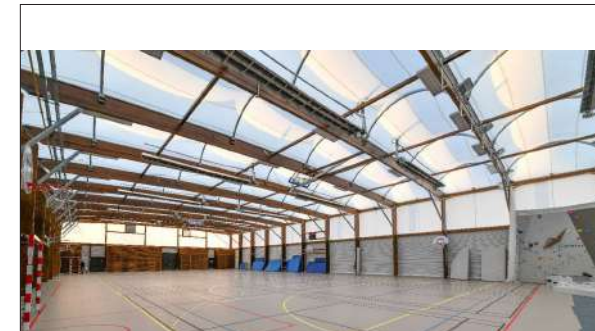
Gymnase de Annonay OLIVIER BONZON Architecte
