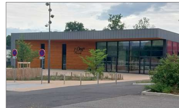
Salle des fêtes de Sury-le-Comtal Vindry Archi
