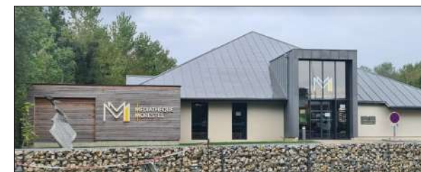
Médiathèque de Morestel ARCANNE Architectes
