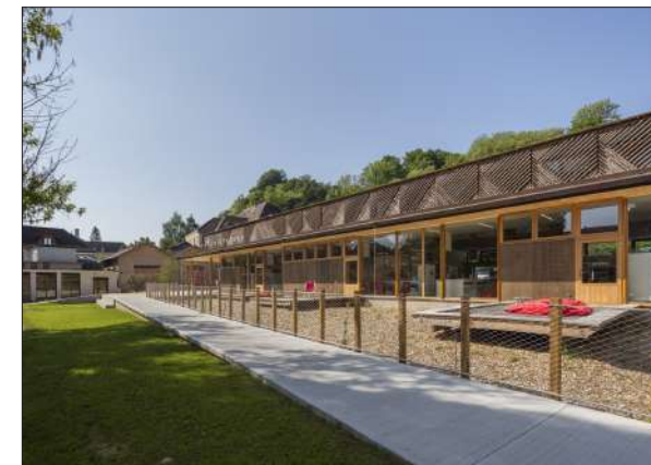
Médiathèque de Pont-de-Beauvoisin Atelier 43
