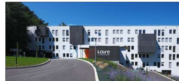
Restructuration immeuble Rue Paul Petit Département 42 Atelier des Vergers
