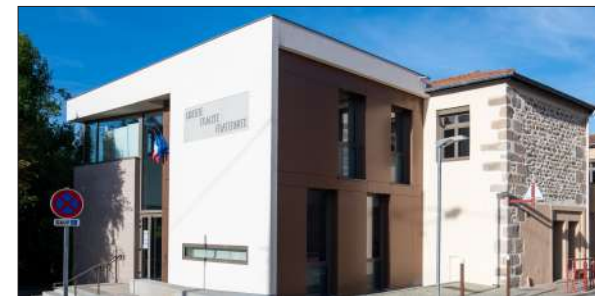
Restructuration de la mairie de Sorbiers JAMBRESIC architecte
