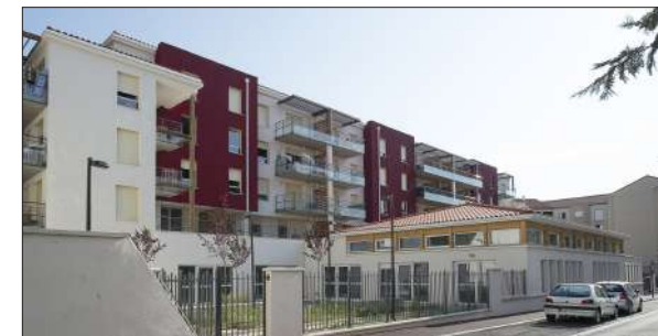
30 logements à St Chamond XXL Architecture
