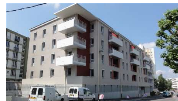
30 logements au Chambon-Feugerolles J-M DUTREUIL et J-J FERRET
