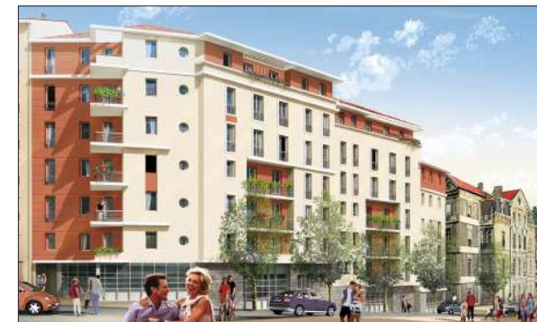
50 logements à St Chamond BERAUD Architecture Ingénierie
