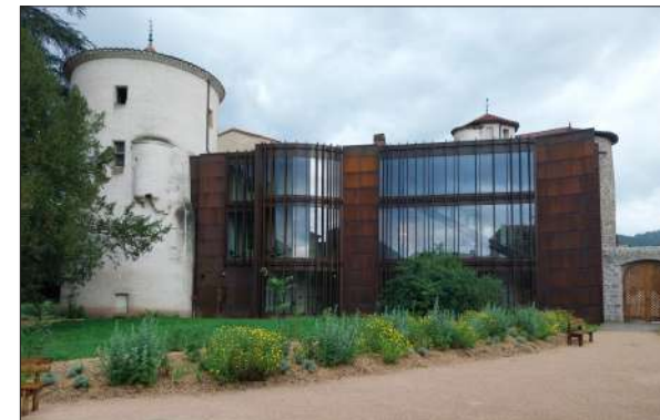
Château de Aurec-sur-Loire CROISEE D'ARCHI
