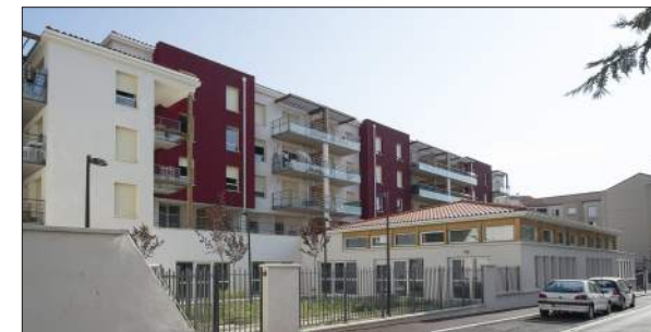
30 logements à St Chamond XXL Architecture
