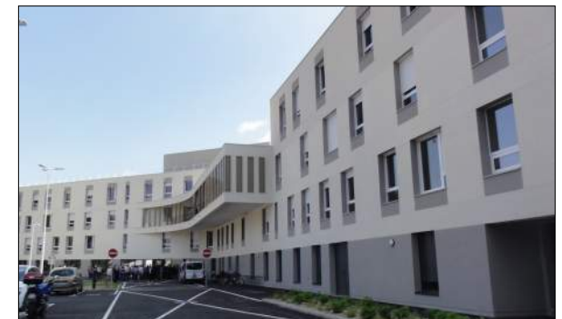
CENTRE HOSPITALIER DE CONDRIEU Groupement VINCI construction, CHABANNE et partenaires
