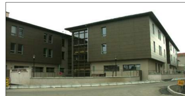
Maison de retraite de St Just St Rambert A. DUVERGER et Ph. BLANC Architectes
