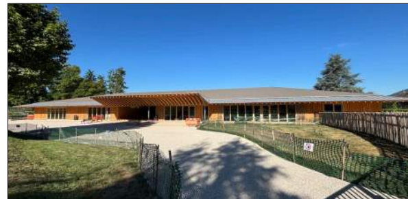
Ecole maternelle à Coublevie GALLET Architectes
