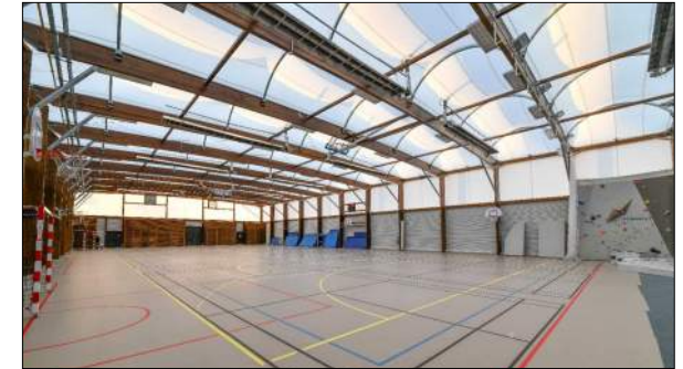
Gymnase de Annonay OLIVIER BONZON Architecte
