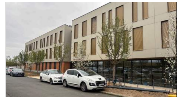
Siège communauté de communes des Pays de l'Arbresle Gallet Architecte
