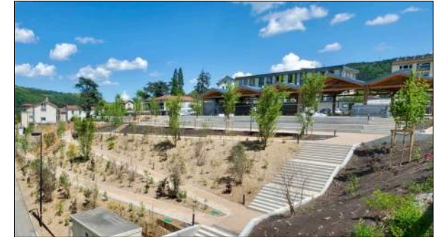
Construction d'une halle à Aurec-sur-Loire
