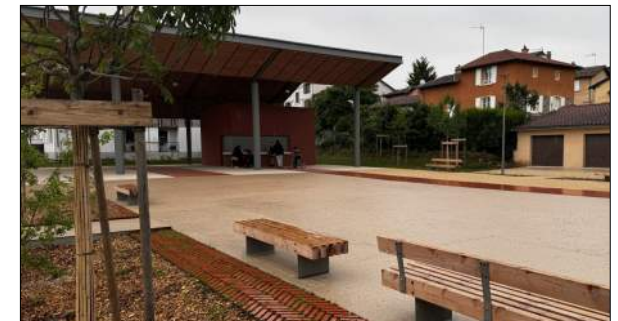
Construction d'une halle à St-Pierre-la-palud
