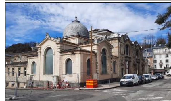
Rénovation d'une aile du bâtiment "Les Grands Thermes" à La Bourboule
