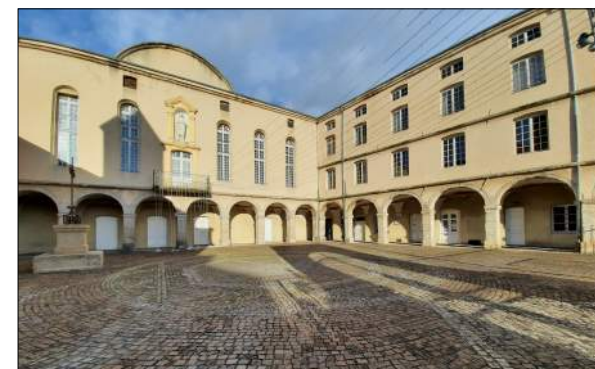
Rénovation de l'Hôtel Dieu de St-Chamond SILT
