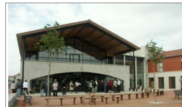
Foyer Les Mûriers à Bussières J-L. MATHAIS Architecte
