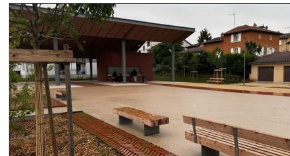
Construction d'une halle à St-Pierre-la-palud
