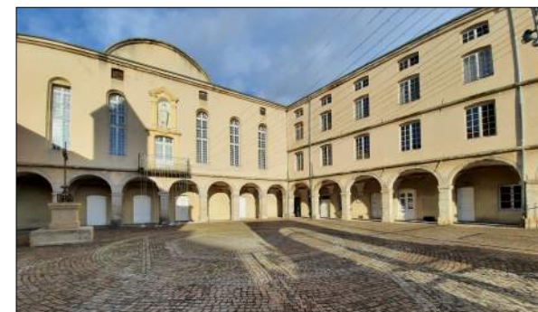
Rénovation de l'Hôtel Dieu de St-Chamond SILT
