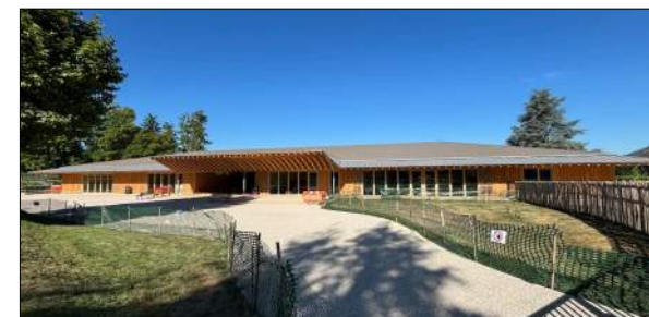
Ecole maternelle à Coublevie GALLET Architectes
