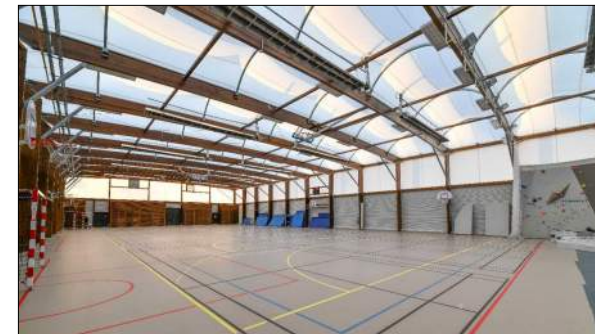
Gymnase de Annonay OLIVIER BONZON Architecte
