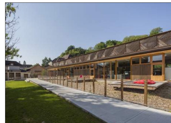
Médiathèque de Pont-de-Beauvoisin Atelier 43
