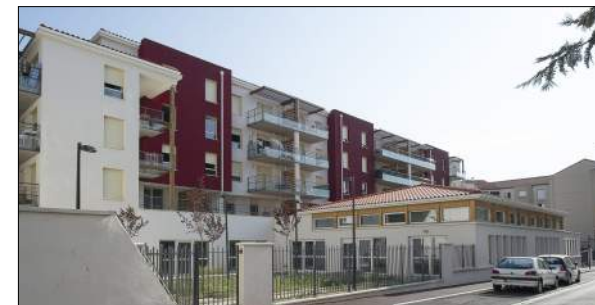
30 logements à St Chamond XXL Architecture
