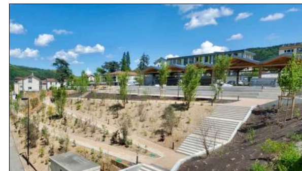
Construction d'une halle à Aurec-sur-Loire
