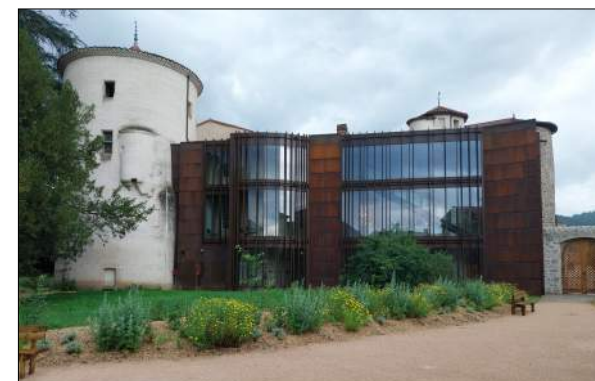
Château de Aurec-sur-Loire CROISEE D'ARCHI
